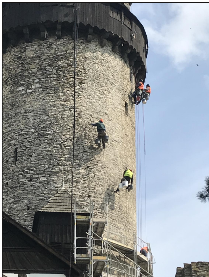
Doplnění zdiva a spárování tubusu věže
