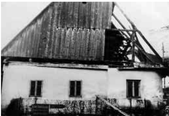
Demolice čp. 243 (podzim 1983).
