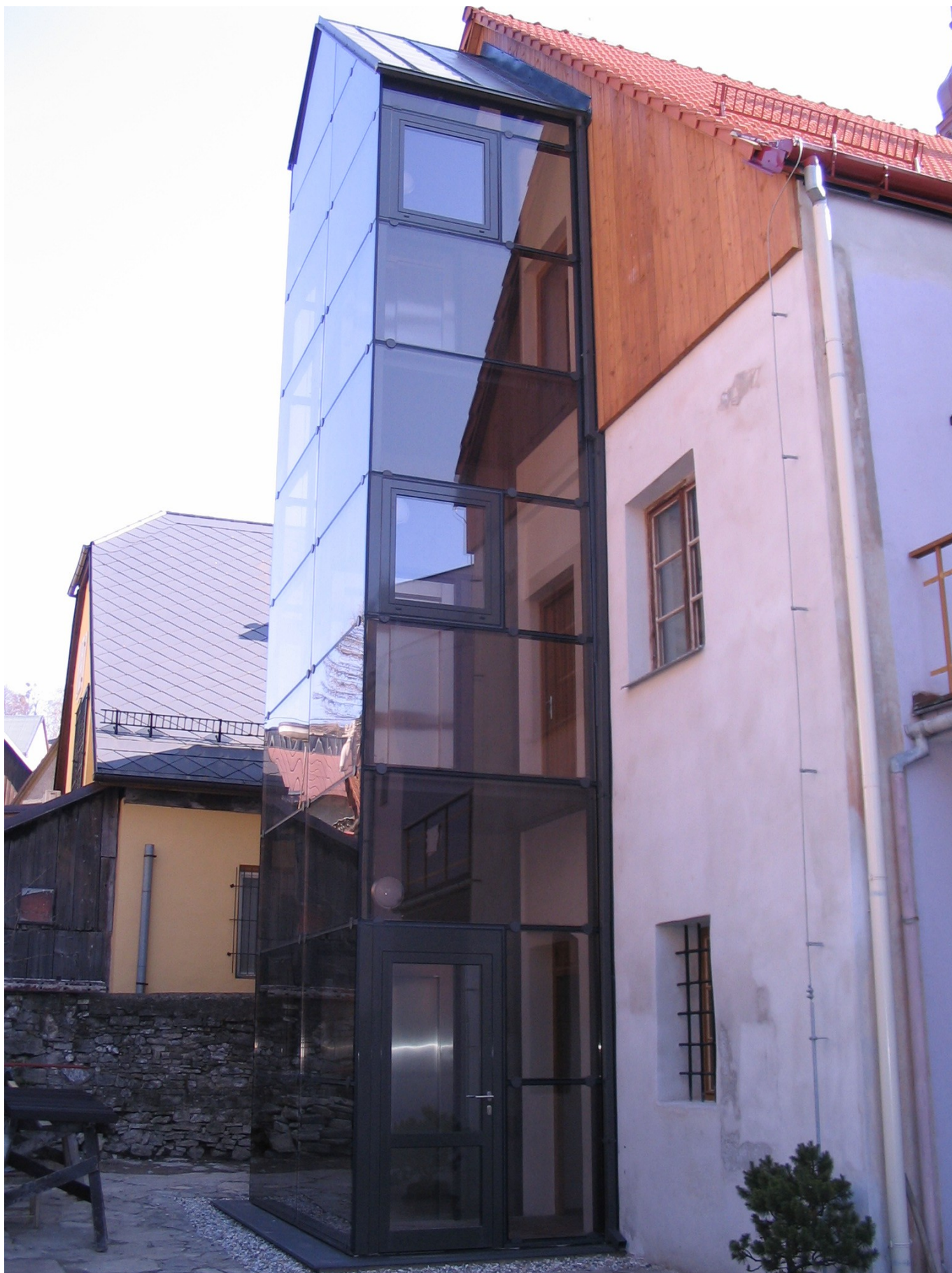
Obrázek 4 – výtahová šachta s osobním výtahem
