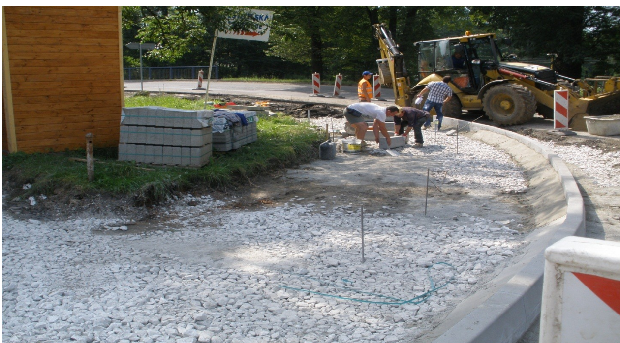
Obrázek č.7 Úprava hlavní trasy 1000 u zastávky
