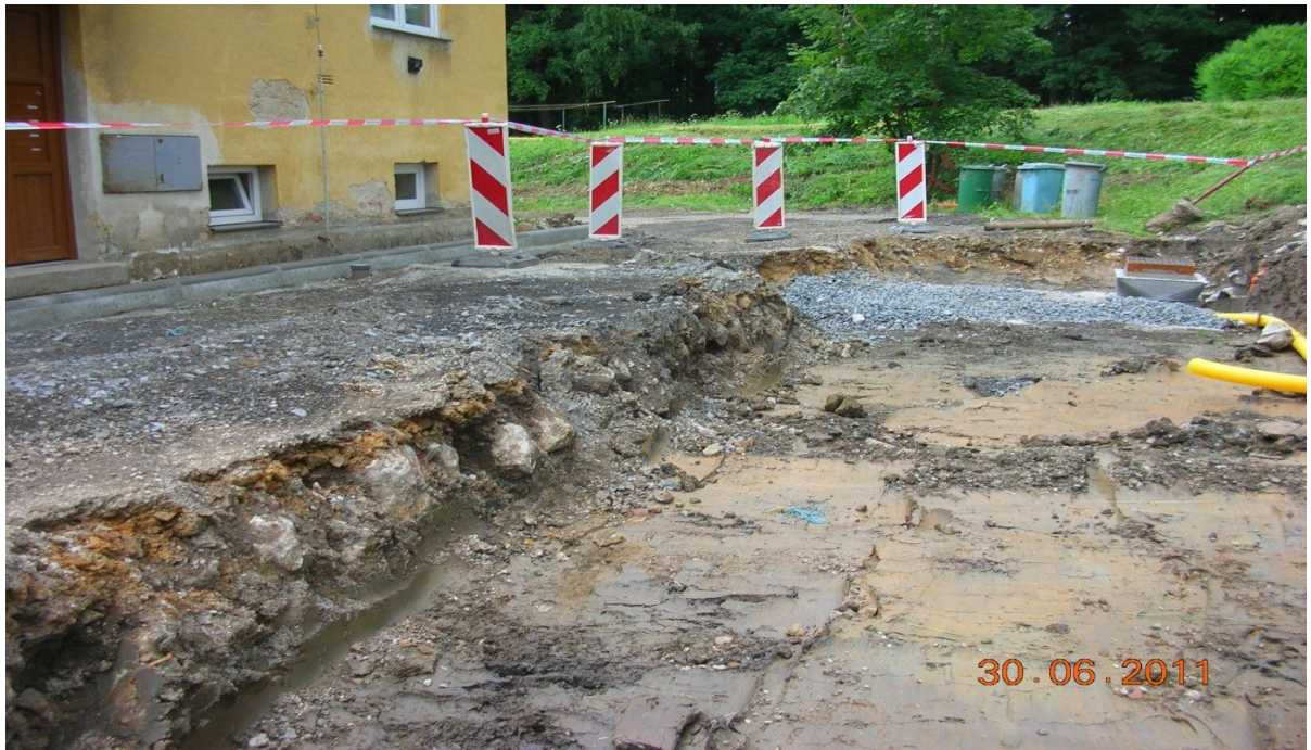
Obrázek č.2 Rozšíření podkladů pro parkoviště
