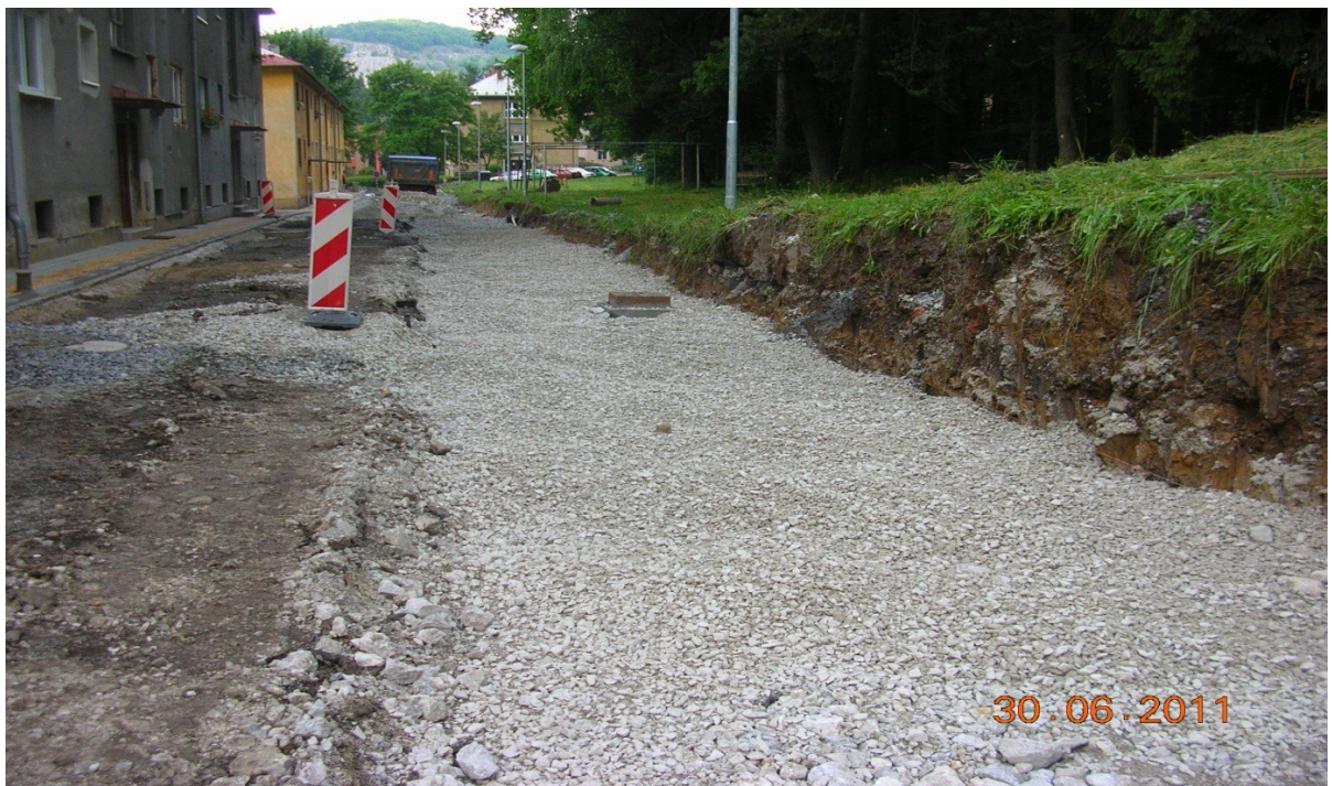
Obrázek č.3 Sanace podloží a podkladních vrstev
