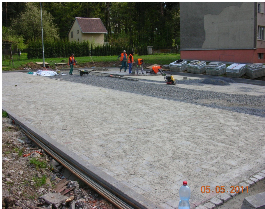
Obrázek č.1 Stavba parkoviště
